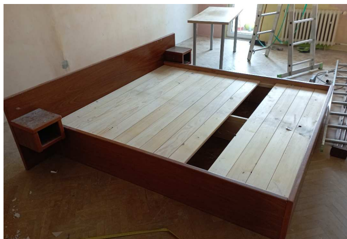
Malování a oprava majákového bytu na Zahradním městě.
